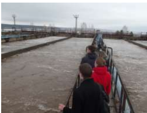
№4 Песколовки аэрируемые
